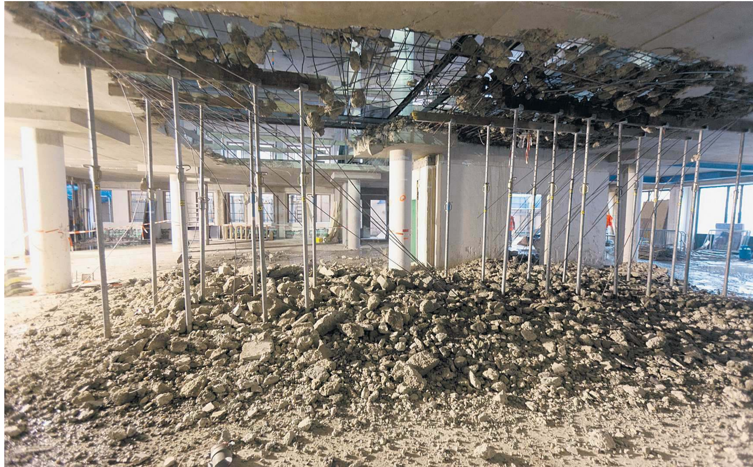
Begane grond, bij het doorbreken van de eerste etage voor de bouw van de vide.
