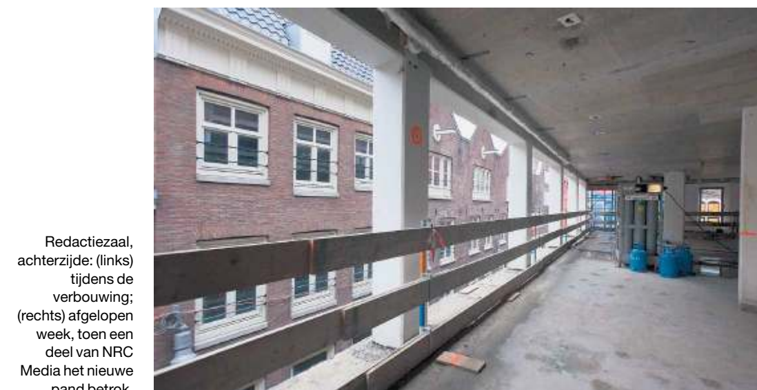
Begane grond, bij het doorbreken van de eerste etage voor de bouw van de vide.
