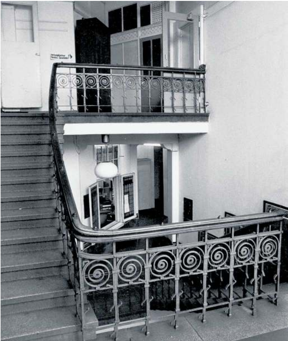
Trappenhuis van het Handelsblad aan de Nieuwezijds Voorburgwal.
